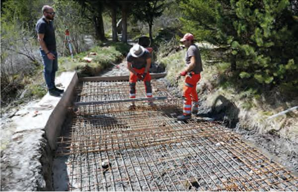
Radier en béton créé pour retenir les sédiments
