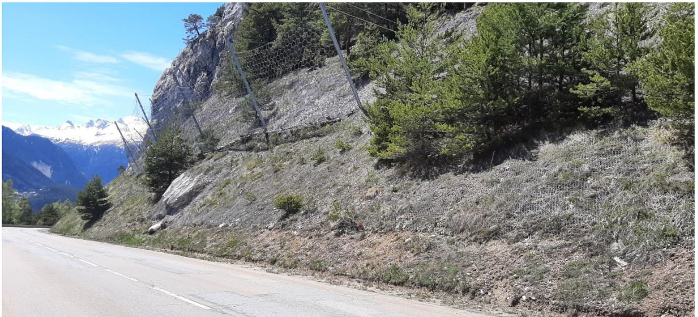
Figure II.8: Filets pareblocs, à l'ouest du projet et en amont de la RD215.
