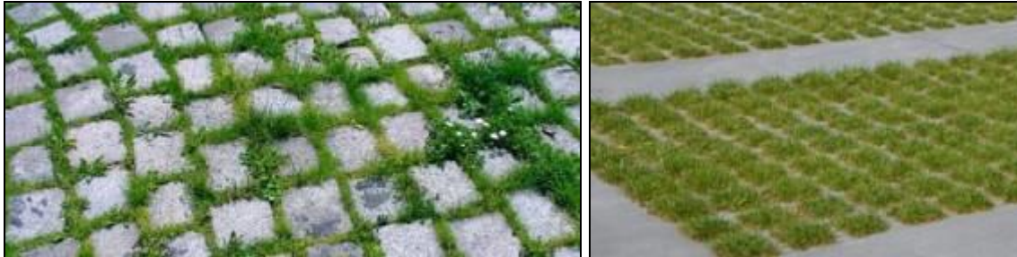
Ex. de traitement de sol limitant l'imperméabilisation
