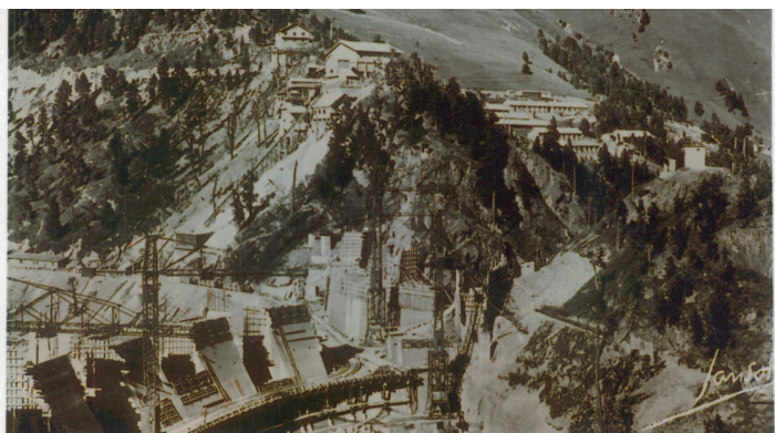
Construction du barrage de Plan d'Aval
