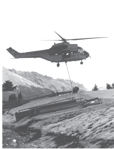
Construction du télésiège du Gran'Jeu, 1982.
